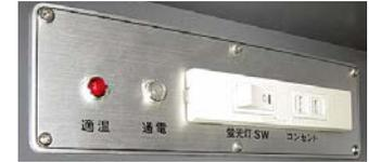
給湯器の状態をスイッチ付コンセントの隣にあるランプでお知らせします。沸かし上げ中は白ランプが、沸かし上がると赤ランプが点灯します。
