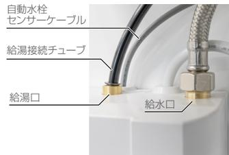
自動水栓とは給湯接続チューブとセンサーケーブルをワンタッチで接続します。
